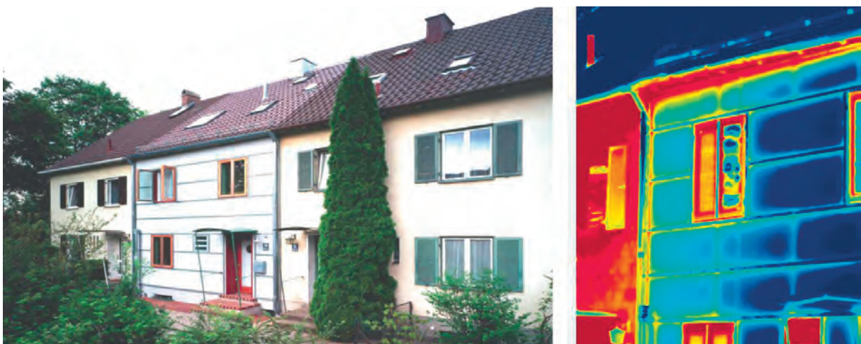
Abb. 5: Mit Vakuumisolationspaneelen energetisch saniertes Reihenmittelhaus (Baujahr 1956). Der U-Wert der hier gezeigten Nordfassade konnte von ursprünglichen 1 \text{ W/(m}^2\text{K)} auf 0.15 \text{ W/(m}^2\text{K)} reduziert werden. Die entsprechende Thermografieaufnahme in der rechten Bildhälfte zeigt die mit verminderten Wärmeverlusten einhergehende deutlich erniedrigte Außenwandtemperaturen (blaue Farben).
