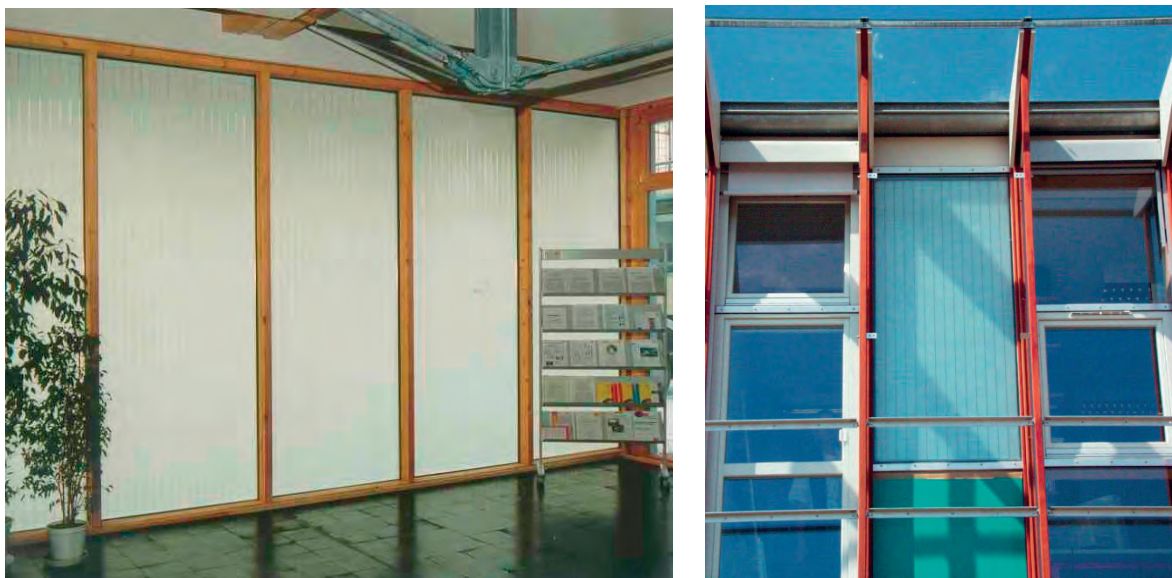
Abb. 8: Innenansicht (link) und Außenansicht (rechts) zweier Anwendungsbeispiele für transparente Wärmedämmungen aus Aerogelgranulat in Doppelstegplatten. Mit einem Wärmedurchgangskoeffizienten U = 0.4 \text{ W}/(\text{m}^2 \text{K}) und einem Gesamtenergiedurchlassgrad g = 0.4 erreicht man auch an der Nordseite eines Gebäudes über die Heizperiode eine ausgeglichene Energiebilanz.
