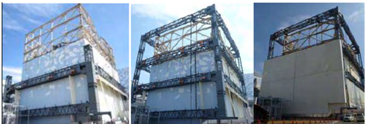
Abbildung 4: Errichtung eines Stahlgerüsts mit Umhausung für Reaktorblock 1 [3].
