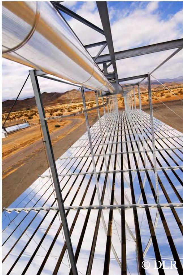
Abbildung 4: Beispiel eines Fresnel Kollektors, Quelle: DLR
