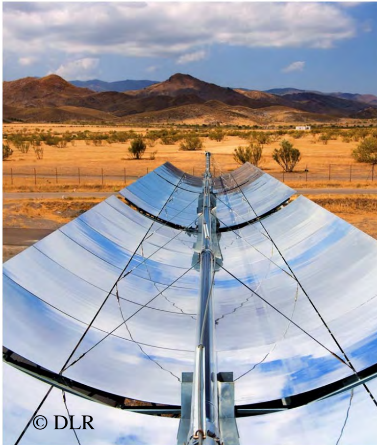
Abbildung 2: Beispiel einer Parabolrinne, Quelle: DLR
