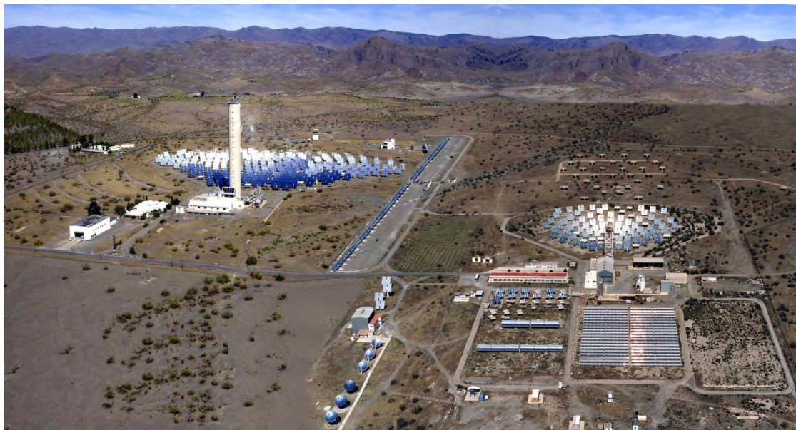
Abb. 1: Testzentrum Plataforma Solar in Almería (Spanien)
