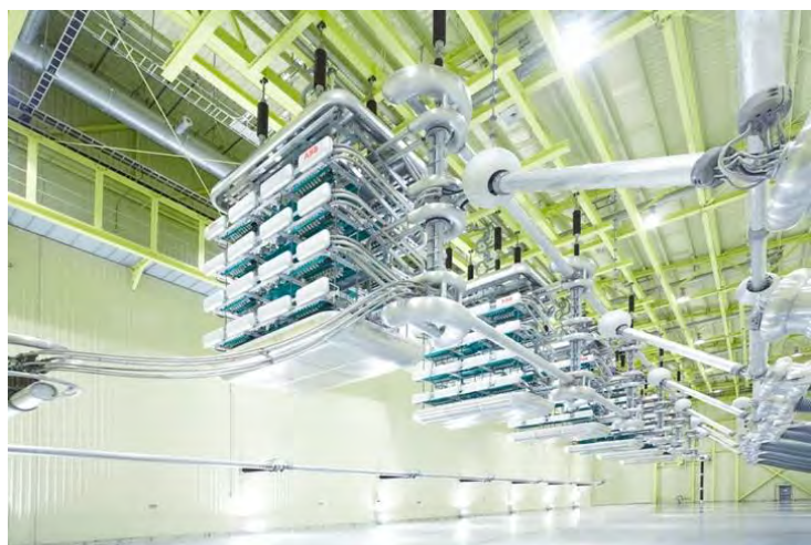
Abb. 6: Links: UHVDC-Verbindung Xiangjiaba – Shanghai, China. Rechts: Ventilhalle in Fengxian [Quelle: ABB].
