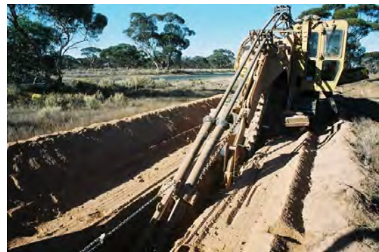
Abb. 8: Links: Landkabelverbindung Murraylink in Australien. Rechts: Kabelverlegung.
