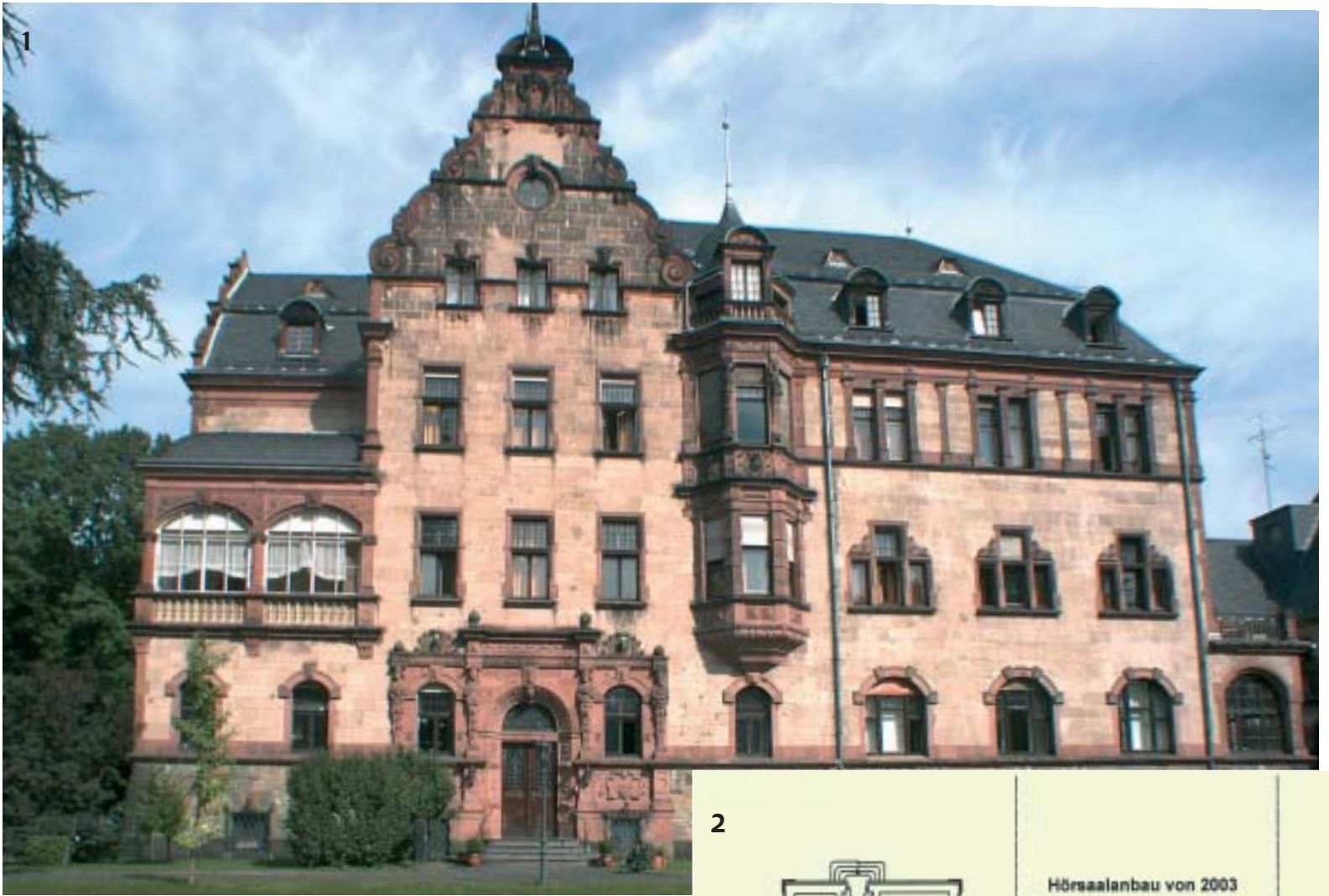
1) Westfassade des Hauptgebäudes. (FH Köln)
